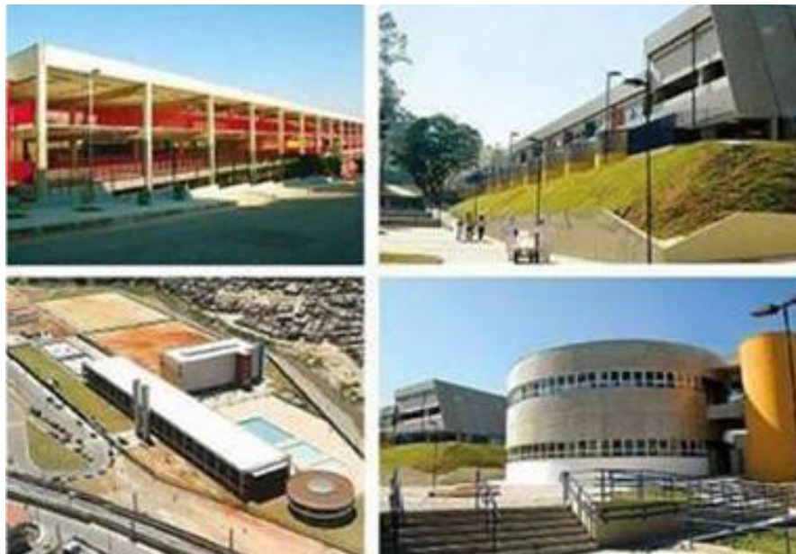
Vista Geral do CEU Vila do Sol
